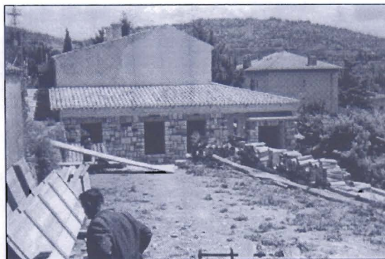
Gradnja počitniškega doma v Portorožu
